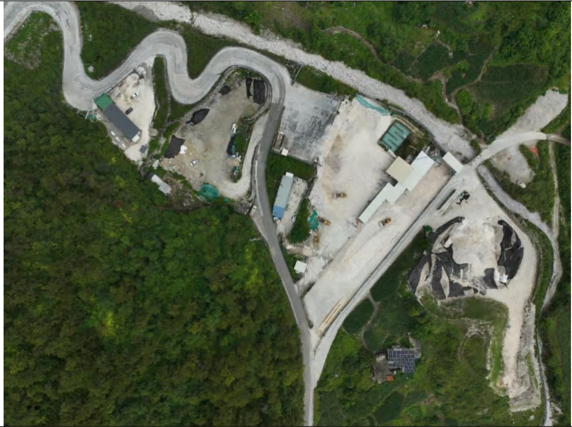
项目区航拍照片
